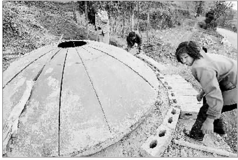
富源县富村镇在抗旱救灾中,立足农村实际,从强化基础设施建设入手,在黑泥潭村迅速新建88个小水窖,每户连同管道补助4500元,容量为20立方米的第三批水窖目前已经陆续完工投入使用。 杨学荣摄
