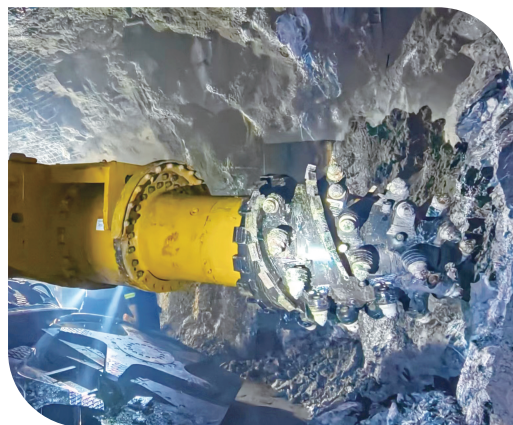
综掘机现场采矿。蔡旭 摄
