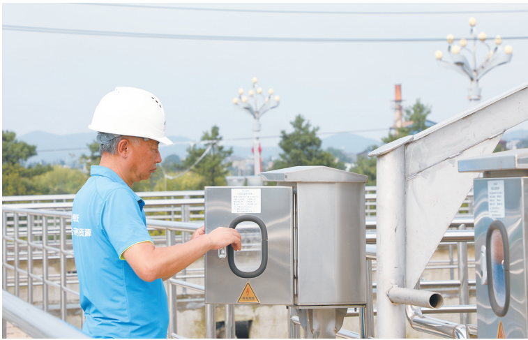
县城污水处理厂二期项目巡检员正在巡检。卢俊欣 摄
