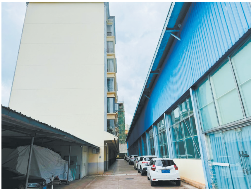
云南玉溪平福园小区内的室内运动场馆,墙体全面铺设吸音棉,靠小区一侧全部更换成双层中空隔音玻璃。
