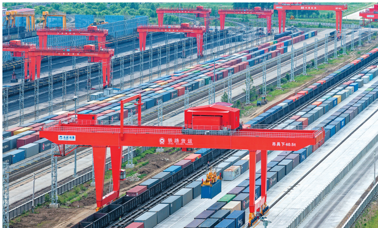
在中国铁路哈尔滨局集团有限公司同江北站换装场,中欧班列进行换装作业。同江铁路口岸地处我国铁路东北部,2022年11月正式开通,是我国最年轻的中欧班列口岸。
