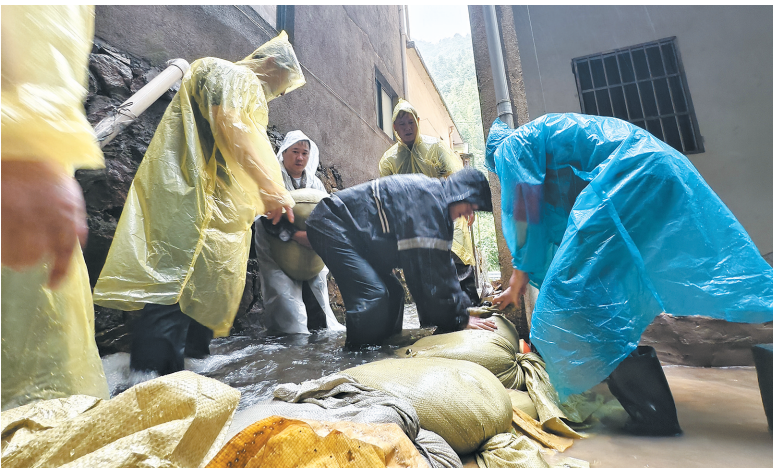
为防御台风“巴威”,浙江省杭州市临安区天目山镇告岭村组织党员干部开展巡查、排险,确保安全无隐患和减少损失。这是告岭村党员干部在堆砌沙包,堵住沟渠倒灌的雨水。 新华社发
