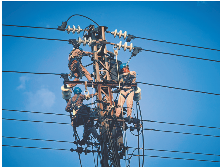
消除安全隐患。钱伟摄
